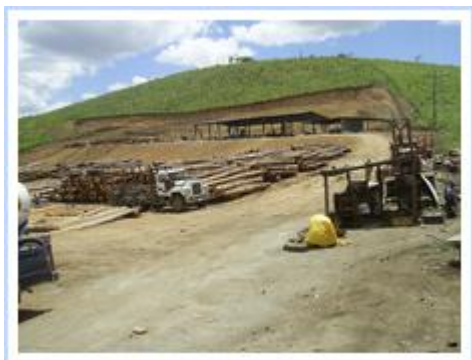
Imagen 1 Vista parcial del Aserradero Santa Elena No. 1
